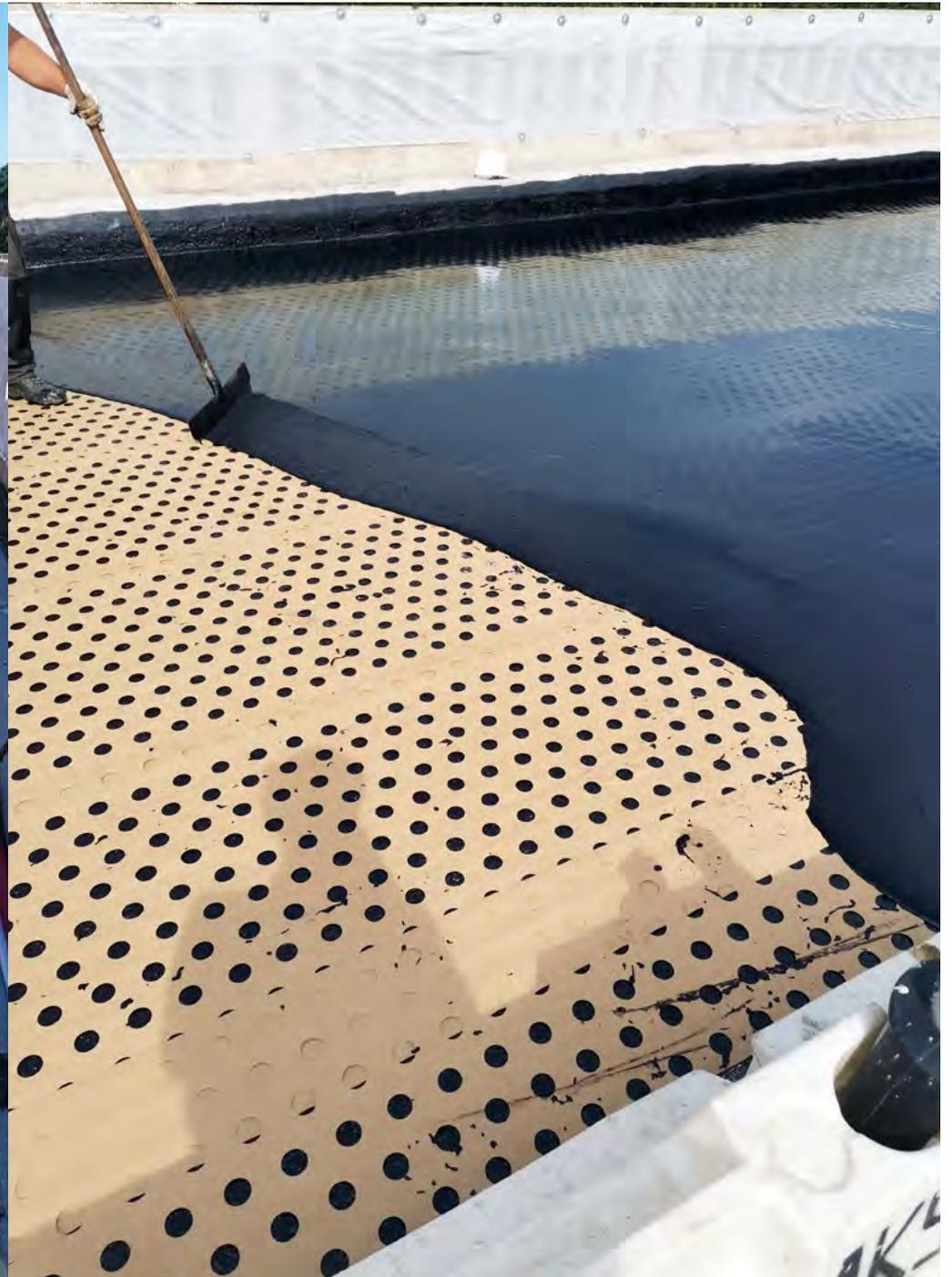
Etanchéité assurée par une couche d'asphalte
