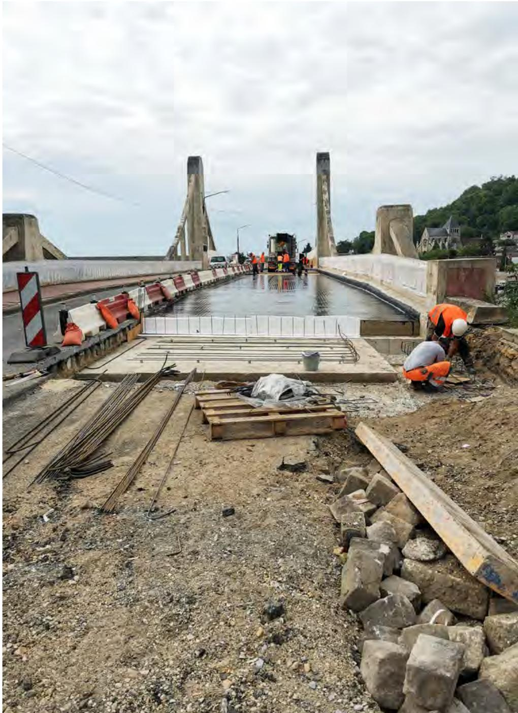
Dalle de transition entre la chaussée et l'ouvrage
