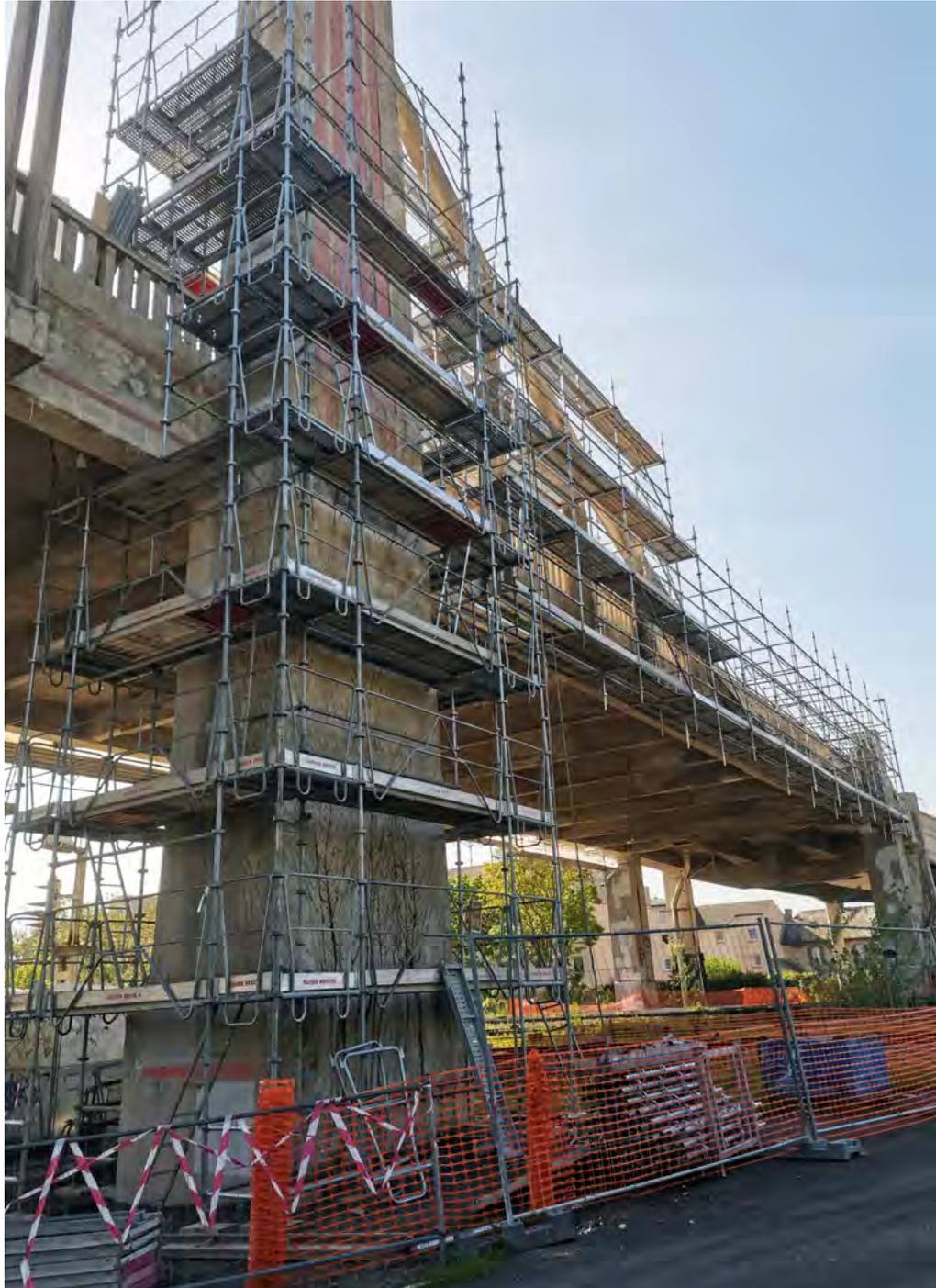
L'échafaudage de la pile centrale a nécessité plusieurs semaines d'installation
