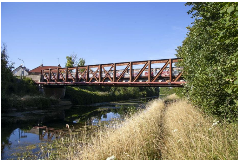
Le pont de Seraucourt avant travaux
