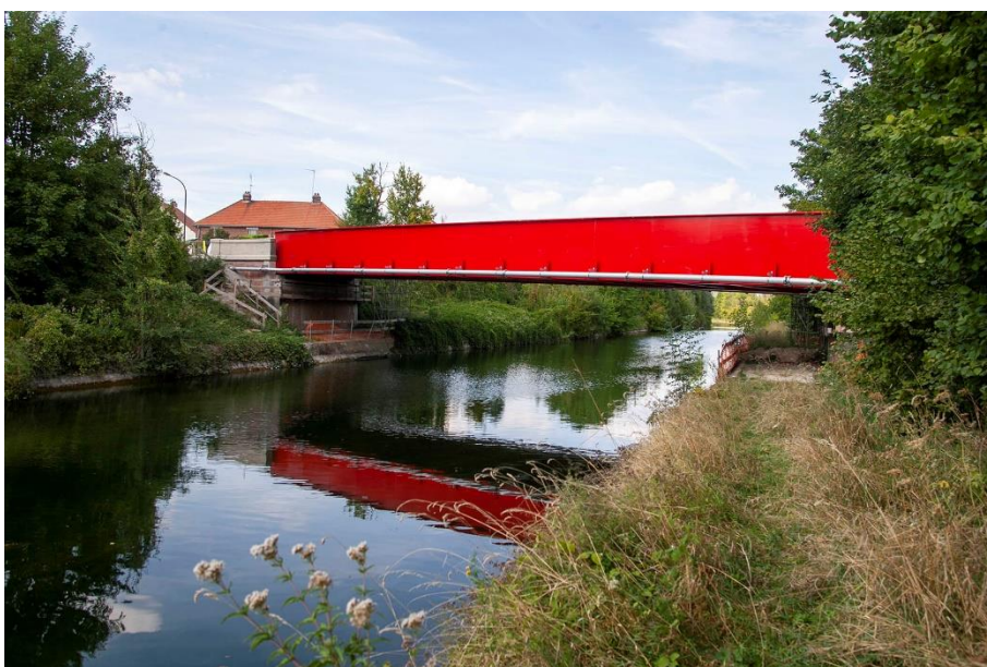
Le pont de Seraucourt après travaux
