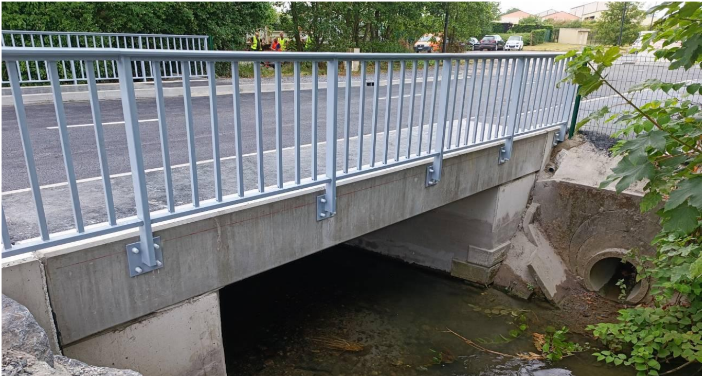
Le nouveau pont du hameau du Pont de Pierre permettant le franchissement de la Simone
