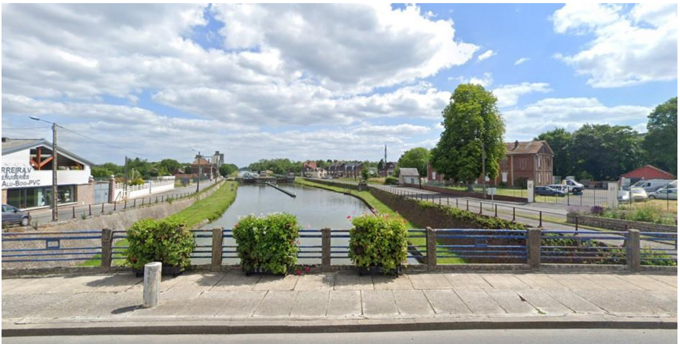
L'ouvrage d'art D0444 sur la RD937 à Chauny avant travaux
