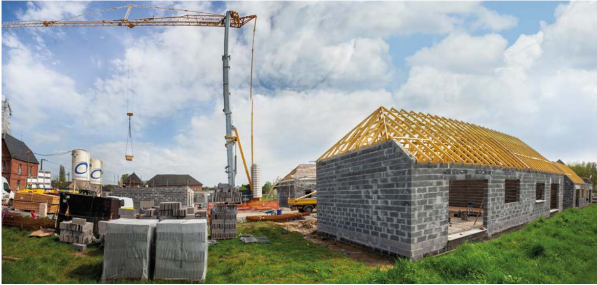
À Boué, un chantier de 4 M€ est lancé
