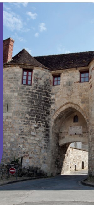
Porte Saint-Pierre à Château-Thierry
