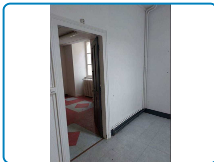
D.O. n° 2 sur Mur Plaque(s) plane(s) fibres- ciment Toile de verre peinte / B
