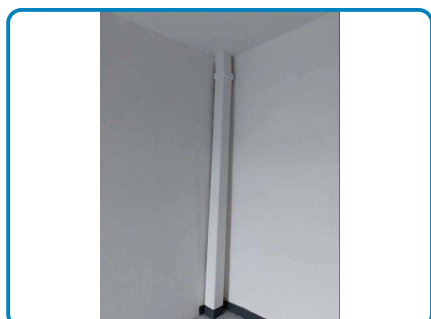
D.O. n° 6 sur Gaine Fibres-ciment / C
