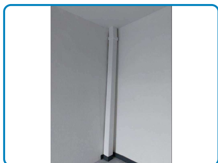
D.O. n° 6 sur Gaine Fibres-ciment / C
