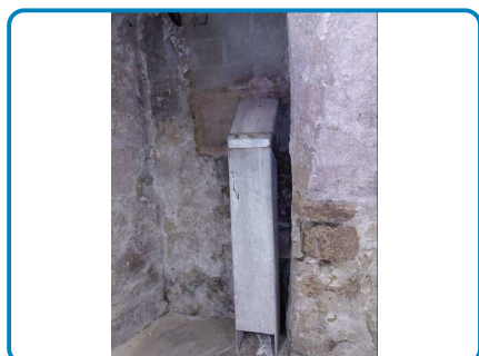
D.O. n° 12 sur Gaine Fibres-ciment / C
